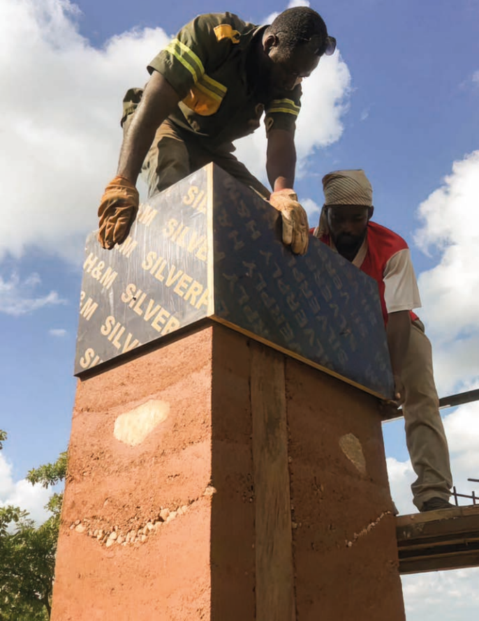
Construção de um muro de terra batida
