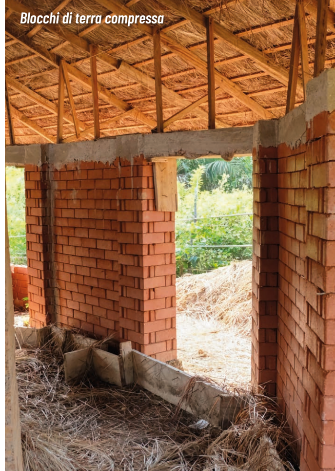
Legno per la struttura del tetto
